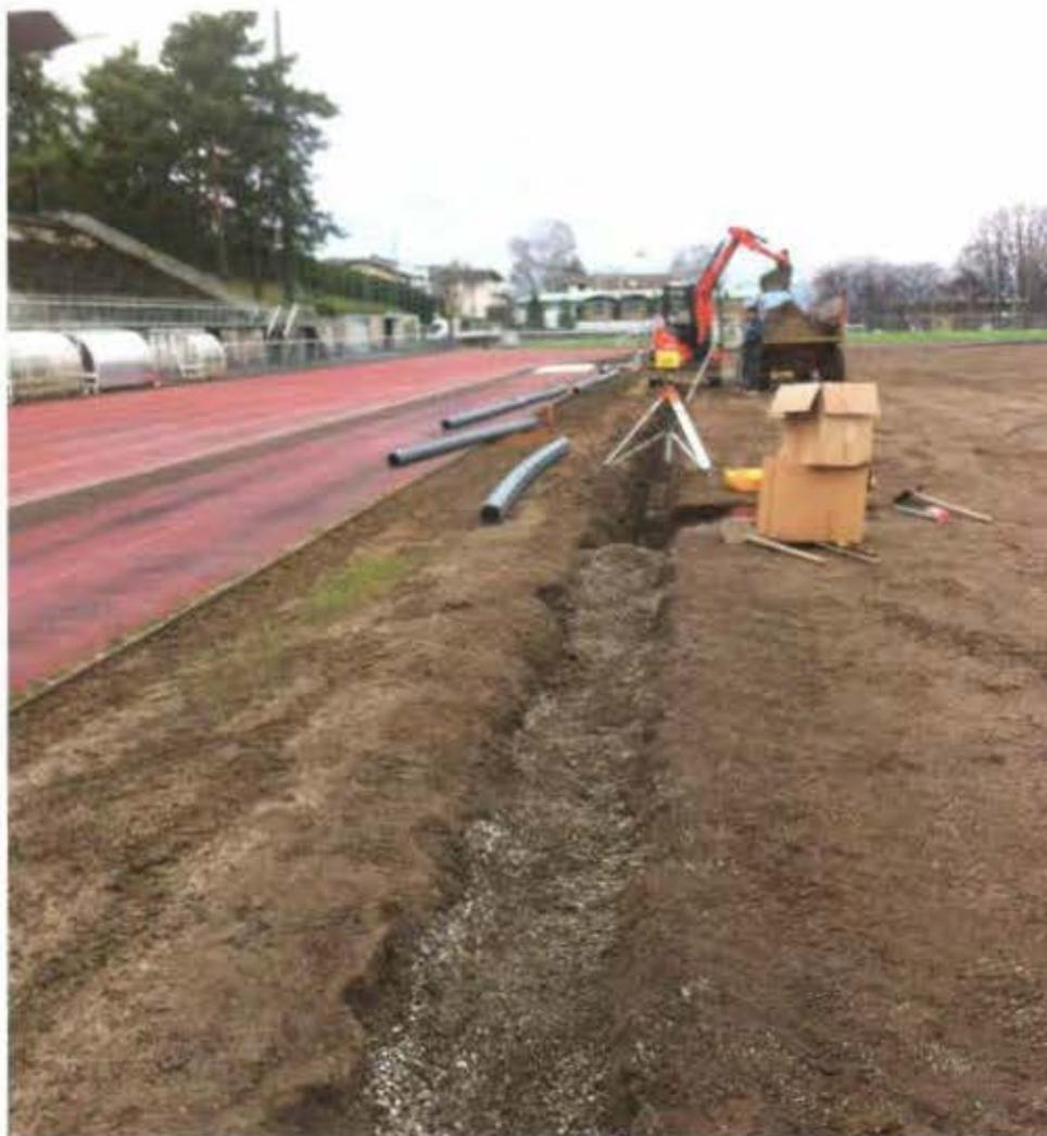
L'entreprise Sotren a mis en place un drainage complet avec des collecteurs en "U", des drains transversaux de diamètre 80, tous les 10 m, des drains longitudinaux et des fentes de suintement de 25 cm de profondeur.
