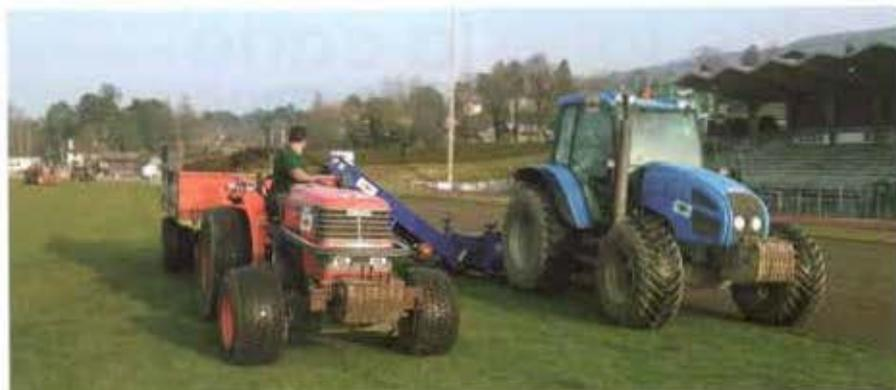
La première partie des travaux a consisté à décaper le gazon sur 4 cm, puis reprendre les pentes avec une niveleuse laser.
